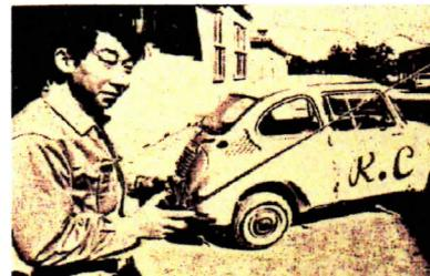
1982 昭和58年 シェル・カーグラフィックマイルレヅマラソンに太陽電池とガソリンエンジンのハイブリッドエコノミーカー【サンシャイン号】を製作して参加。加速時にガソリンエンジン、巡航時は太陽電池の発電でモータ走行するハイブリッド機構を搭載していた。
